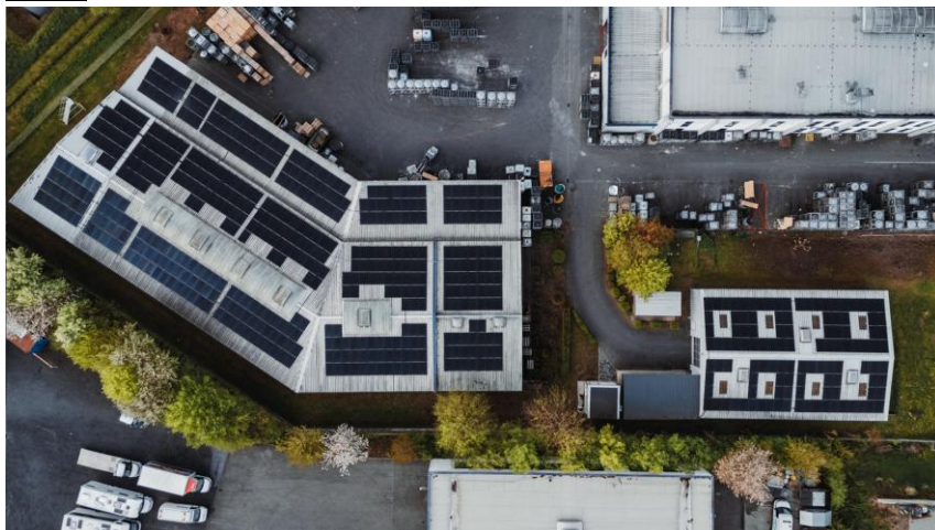
PV-Anlage SWARCO Limburger Lackfabrik in Diez mit insgesamt 600 Glas-Glas-Modulen © enatek GmbH & Co. KG
