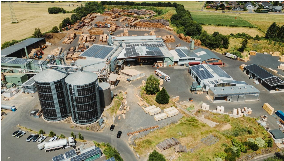
Betriebsgelände Mann Natur in Langenbach mit sieben realisierten PV-Projekten von enatek, darunter auch die Fassadenbegleitung der Pelletsilos (vorn links im Bild)
